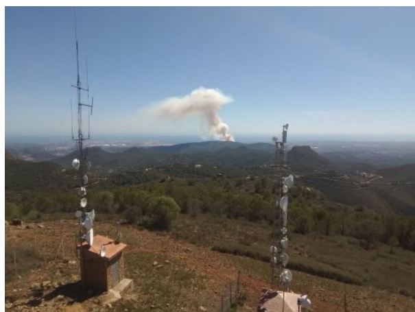
FIGURA 14. Desarrollo inicial de la columna de humo. Fuente: Observatorio Forestal de Alto del Pino.
