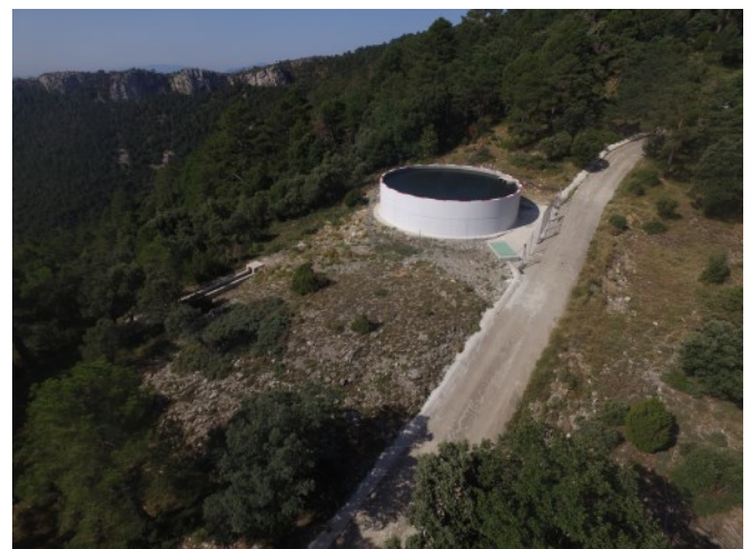
FIGURA 7. Depósito de prevención de incendios
