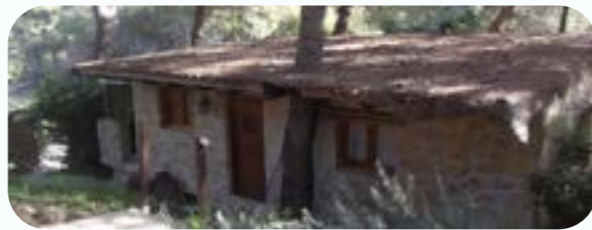
Imatge 167. - Casa que no compleix amb les mesures d'autoprotecció. Font: Medi XXI GSA.
