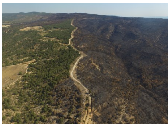
FIGURA 7. Infraestructura de prevención de incendios.
