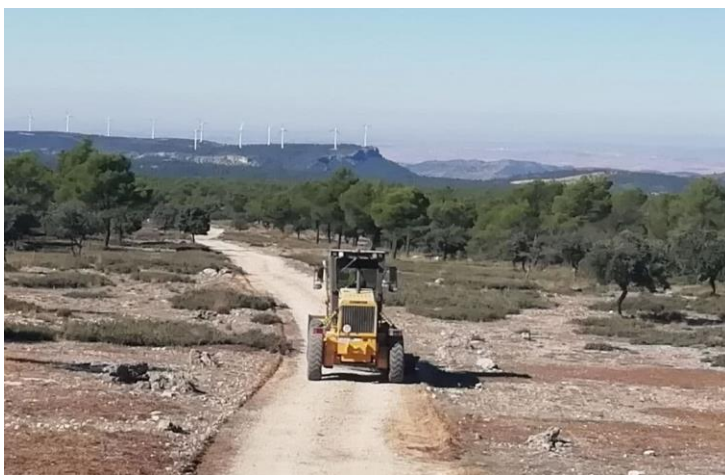
Figura 8. Trabajos de acondicionamiento de las pistas forestales
