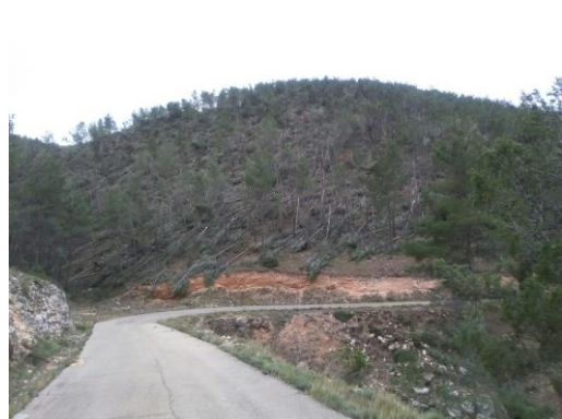
Ladera afectada por caída de pinos (Jalance)
