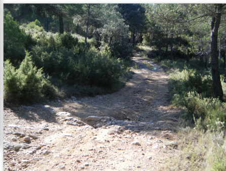
Pistes que no complixen els criteris mínims (amplària menor de 3 m i altura lliure del vial inferior a 4,5 m)
