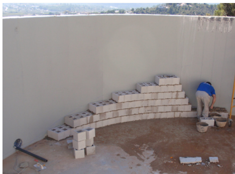
Exemple constructiu d'una rampa.
