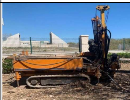
Equipo de perforación
