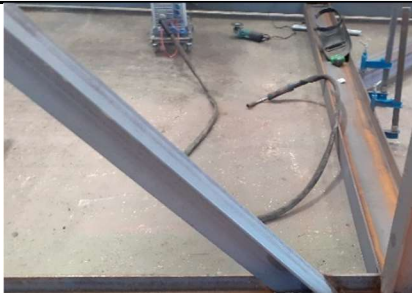
Equips de soldadura i tall
