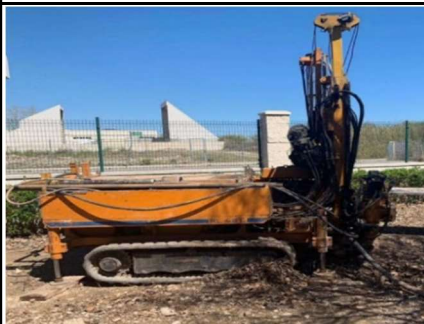
Equip de perforació
